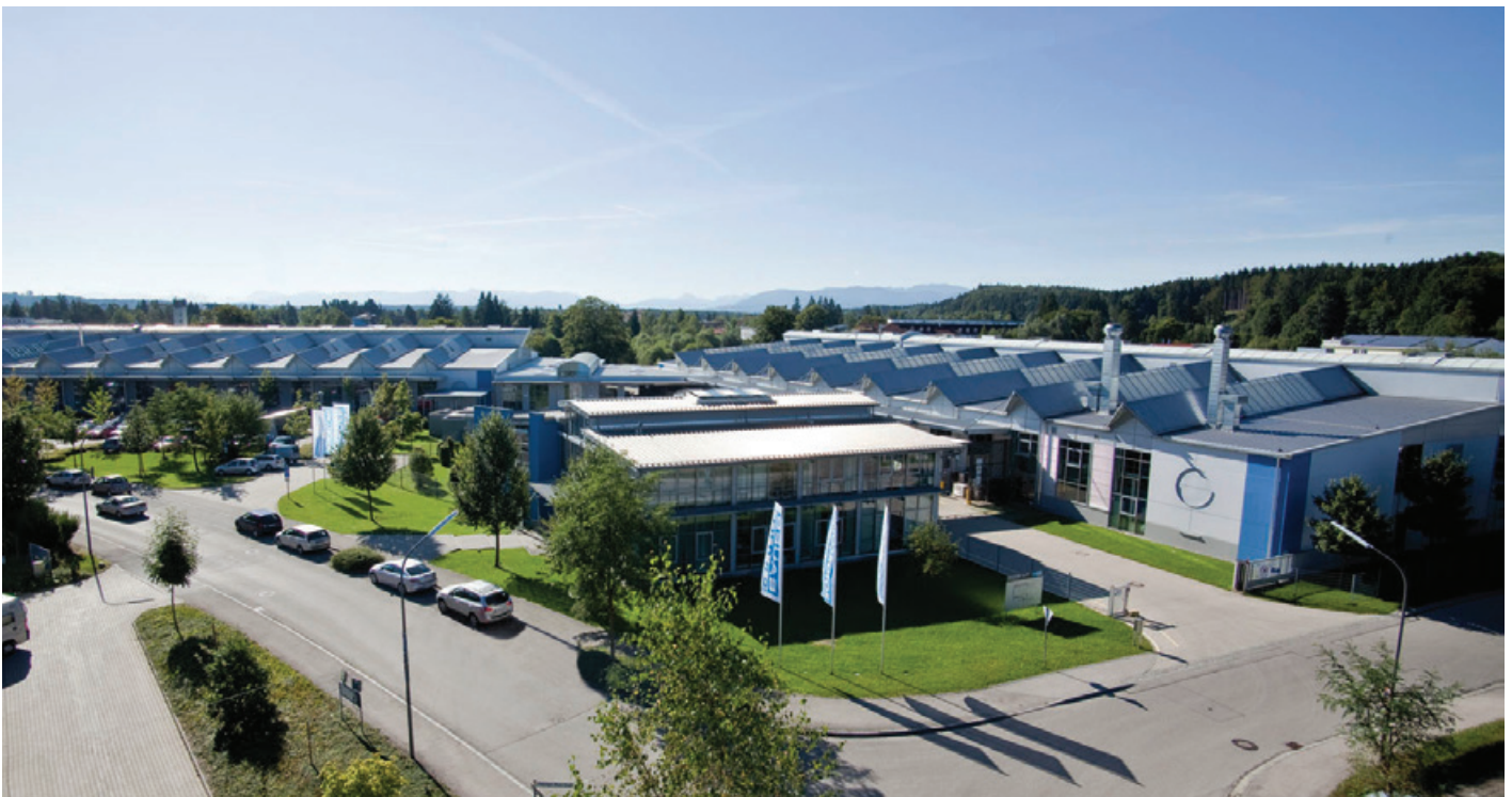
BAUER KOMPRESSOREN Werk I - Geretsried
